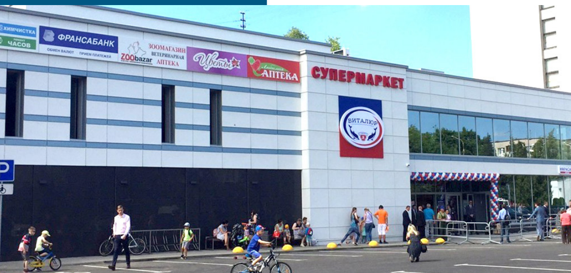
ООО «Виталюр» Реконструкция здания под многофункциональный центр, г. Минск, 4210 м 2
